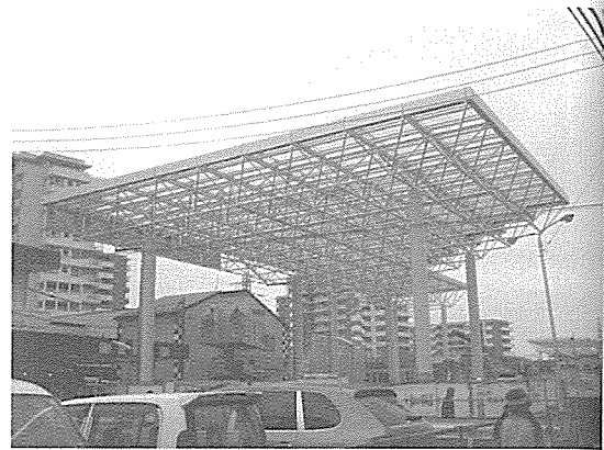
【写真-1】朝霞駅 駅前トラスシェルター
