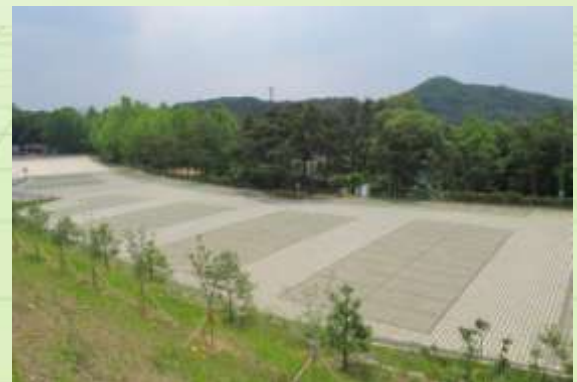
다목적 활용 투수블럭 설치
