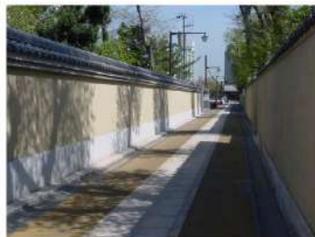
修理・修繕の例
